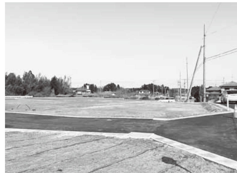
▲災害公営住宅予定地(中村原地区)
