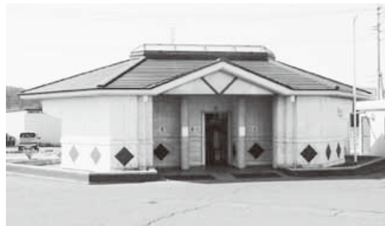
▲道の駅外トイレ
